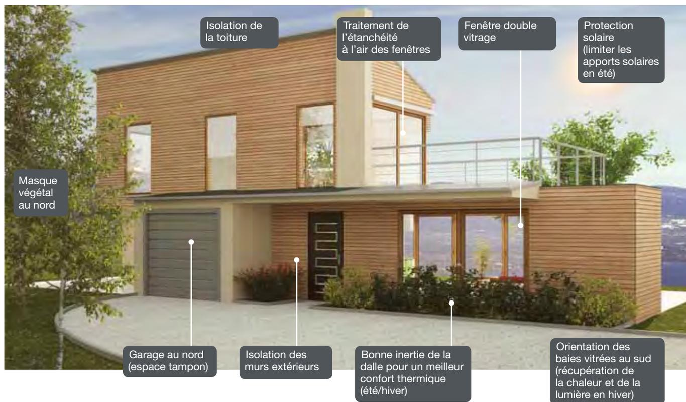
Traitement de l'étanchéité à l'air, double vitrage, isolation des murs extérieurs, etc. : autant de paramètres intervenant dans le calcul de l'indicateur Bbio.
